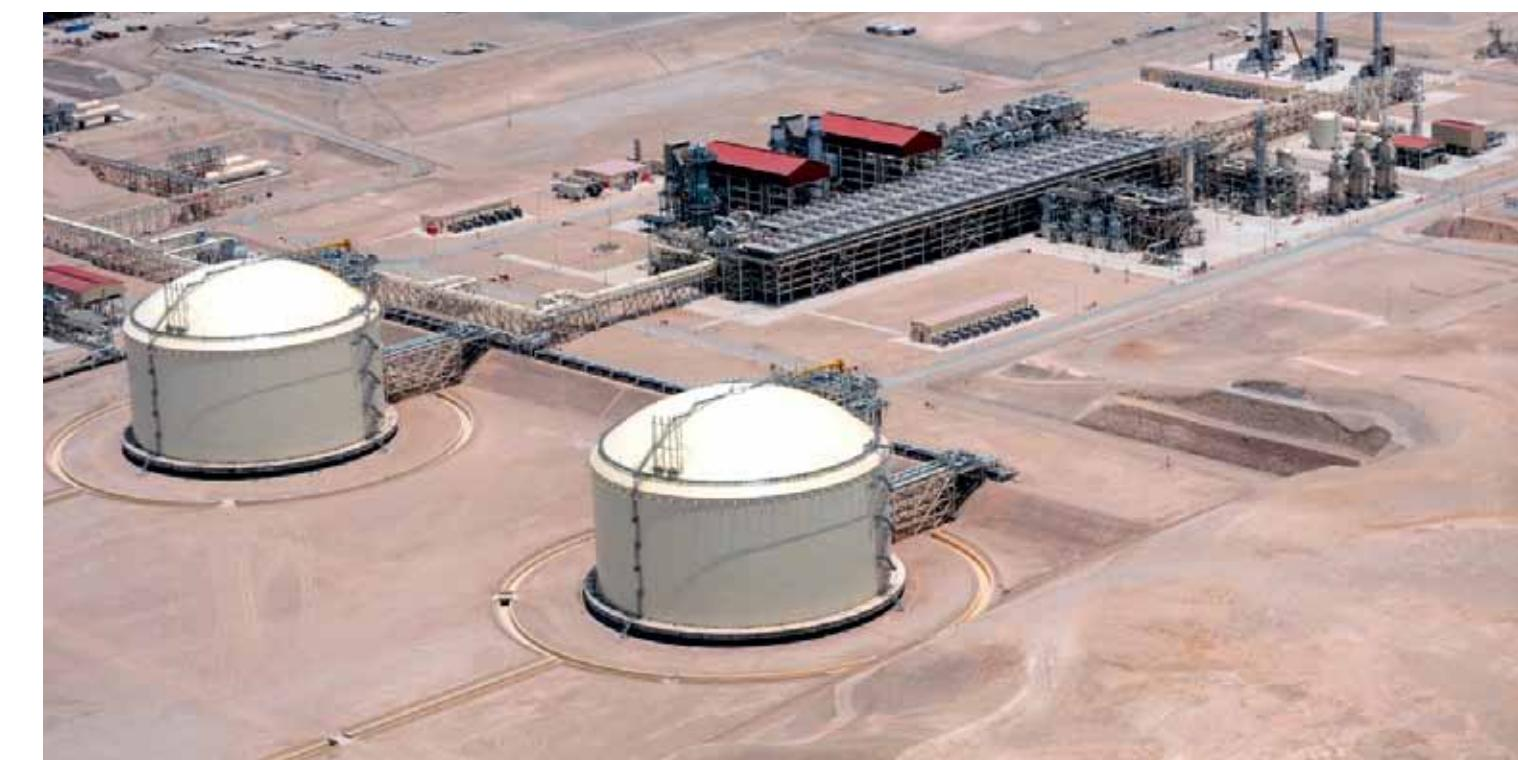
Finalmente, el LNG pasa a los tanques de almacenamiento, de 130,000 m<sup>3</sup> cada uno, antes de ser embarcado a los buques metaneros en el embarcadero de LNG.
