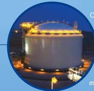
Cada tanque tiene una capacidad de 130,000 m<sup>3</sup>; mide 78 m de diámetro por 52 de alto.
