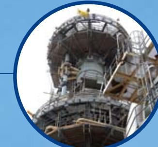
El intercambiador criogénico de calor baja la temperatura del gas natural hasta -163 °C, para volverlo a estado líquido.
