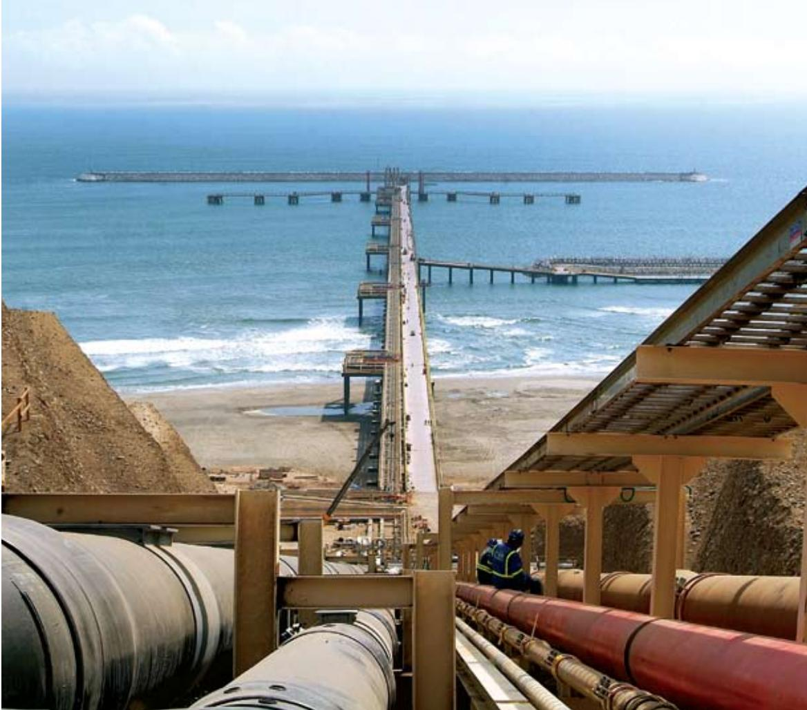
Durante este periodo de carga se necesita que los movimientos del barco sean mínimos para garantizar que el proceso sea ininterrumpido. Por ello los barcos se asegurarán a los llamados delfines de amarre, mientras sean cargados de GNL. El muelle de PERU LNG cuenta con 10 de estos delfines que se encuentran alineados paralelamente a la costa, antes del rompeolas.
