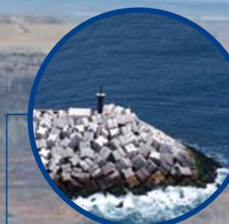
En la construcción del rompeolas se han utilizado más de dos millones de toneladas de roca y cerca de 14,000 grandes bloques de concreto. El rompeolas tiene una extensión aproximada de 800 metros de largo y 25 de ancho.
