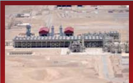
En la planta, se reduce la temperatura del gas (-163°C) para convertirlo en líquido.
